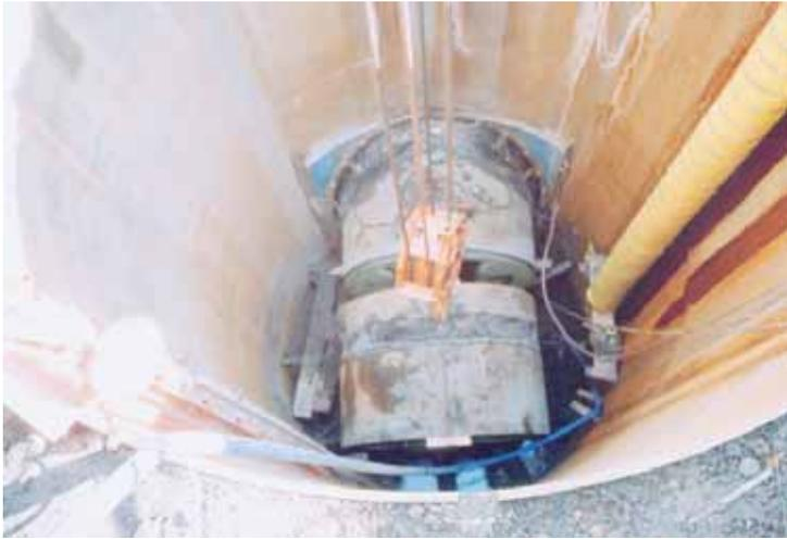
写真 - 5 掘進機到達状況
