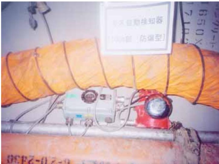
写真 4 可燃性ガス検知器
