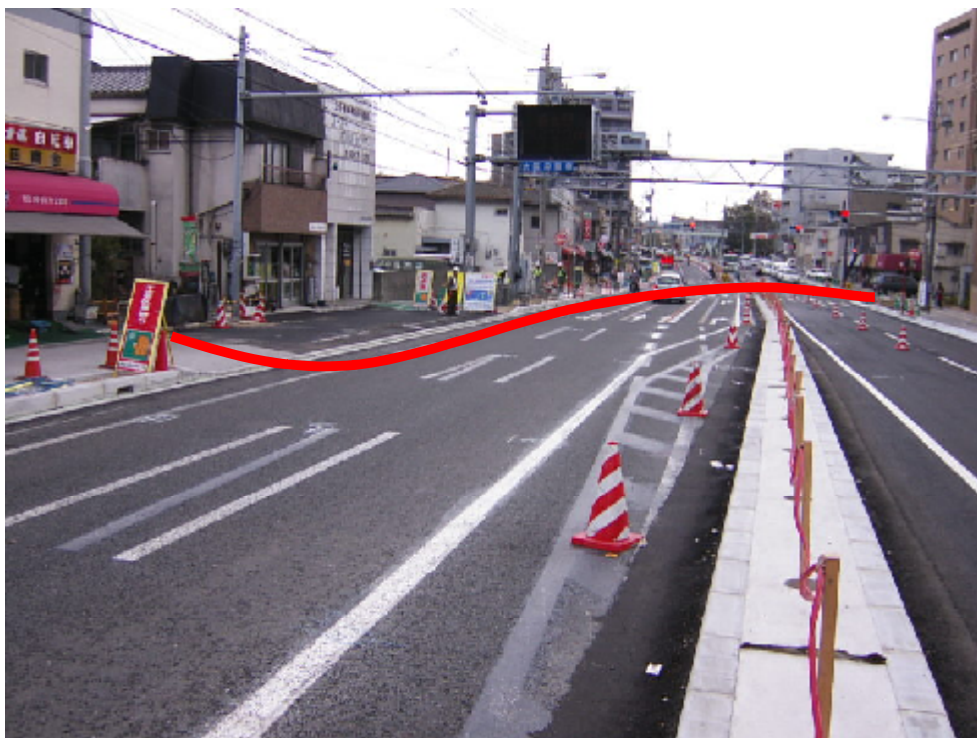
写真 - 2 国道2号線下の推進線形
