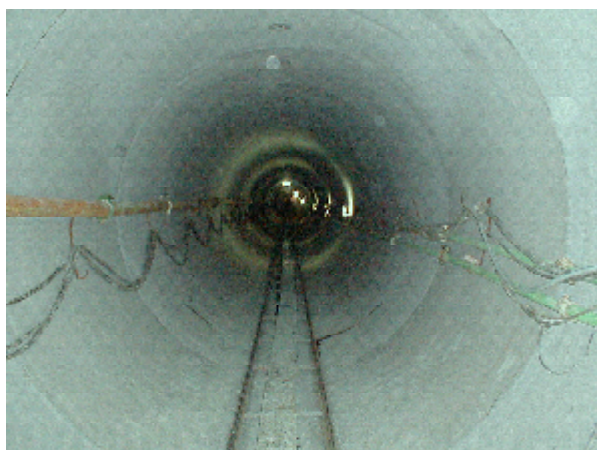
写真 - 5 曲線部管内状況
